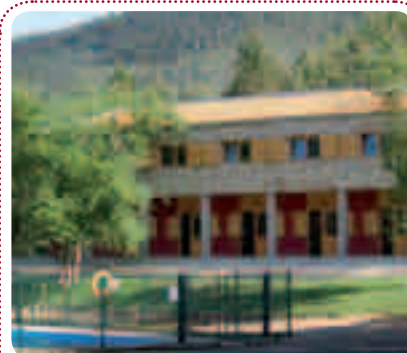
Casa de colonias La Sala
